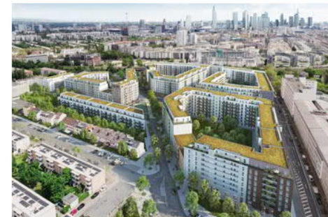
Westville (1.100 Wohnungen) Frankfurt/Main
