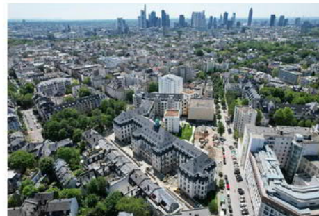
Marienkrankenhaus, 230 Wohnungen + Kita Frankfurt/Main
